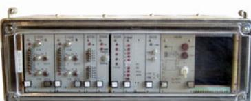
БЛОКИ ЗАЩИТЫ ГЕНЕРАТОРОВ ОТ АСИНХРОННОГО РЕЖИМА ТИПОВ
